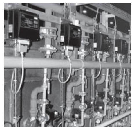
Forno per tempra con numerosi bruciatori per uso industriale installati uno accanto all'altro
